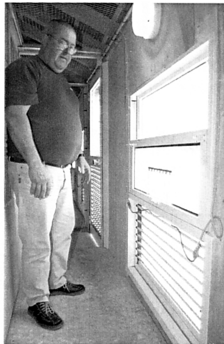
L'aération est réglable grâce à des lamelles en plastique amovibles.
